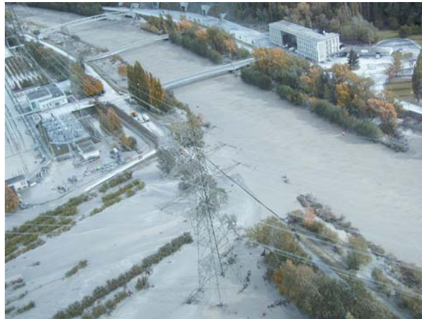
Figure 11: Exemple de la rupture de la digue du Rhône à Chamoson en octobre 2000
